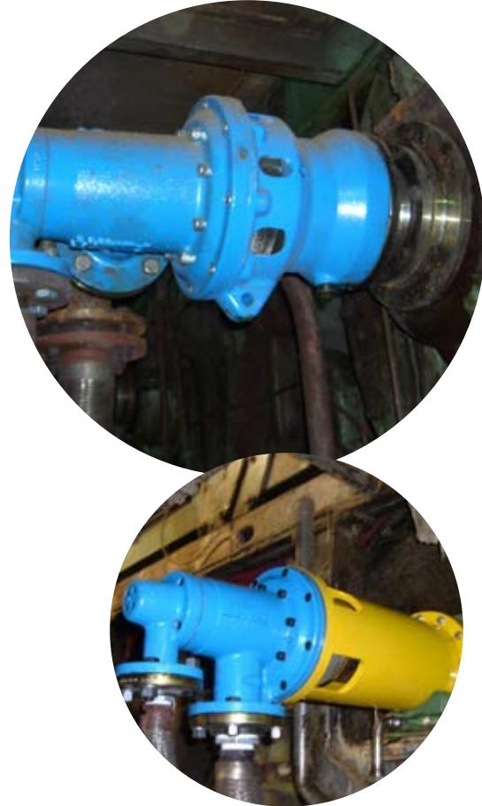
Para conseguir un perfecto drenaje del cilindro, Fomat recomienda instalar sifones fijos con juntas rotativas soportadas por el bastidor de la máquina. En caso de que no se disponga de una estructura de anclaje fija en la máquina, Fomat diseña un **sostén autoportante** capaz de garantizar la estabilidad del propio sifón.
